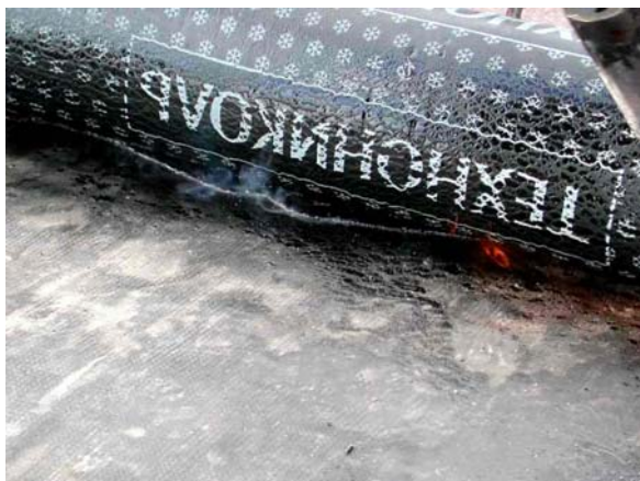
Рис. 15. Валик расплавленного битумного вяжущего.
