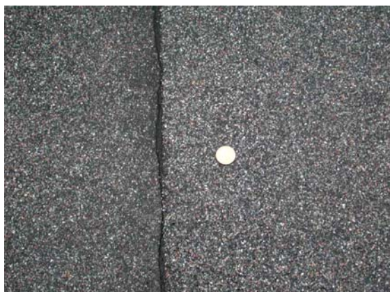
Рис. 16. Битумное вяжущее, вытекшее из-под кромки материала. (для сравнения монета 10коп.)
