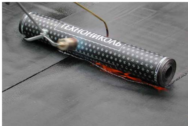
Рис. 15. Валик расплавленного битумного вяжущего.
